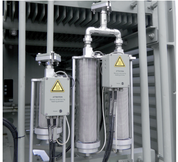
配有过滤网加热器的 MESSKO® MTraB® DB100 和 DB200D-T
